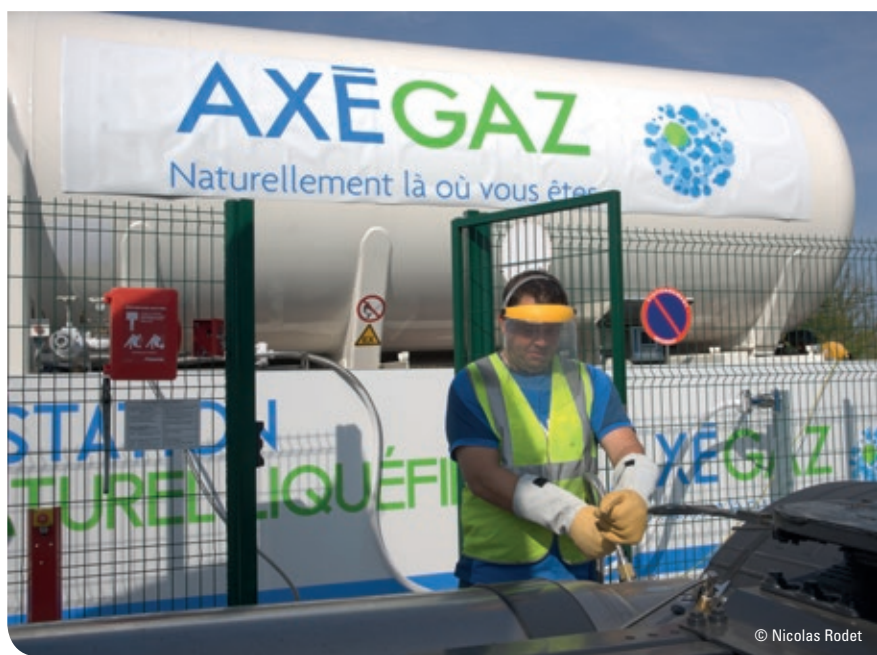
La station GNL d'Axègaz inaugurée en septembre 2014.
